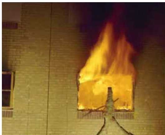
Slika 8 Izlazak plamena nakon rasplamsavanja kroz otvor na zidanoj zgradi [10]
