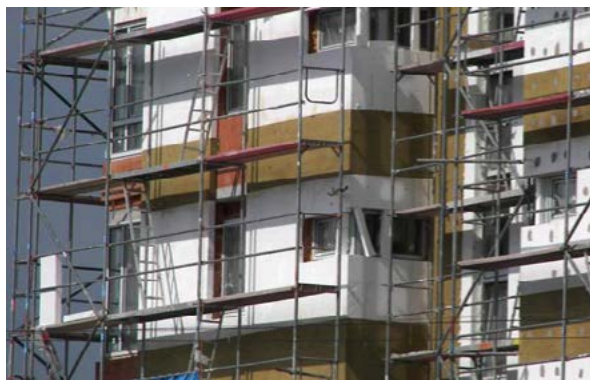
Slika 31 Primjer izvedbe vertikalne prekidne udaljenosti s negorivom izolacijom na pročelju
